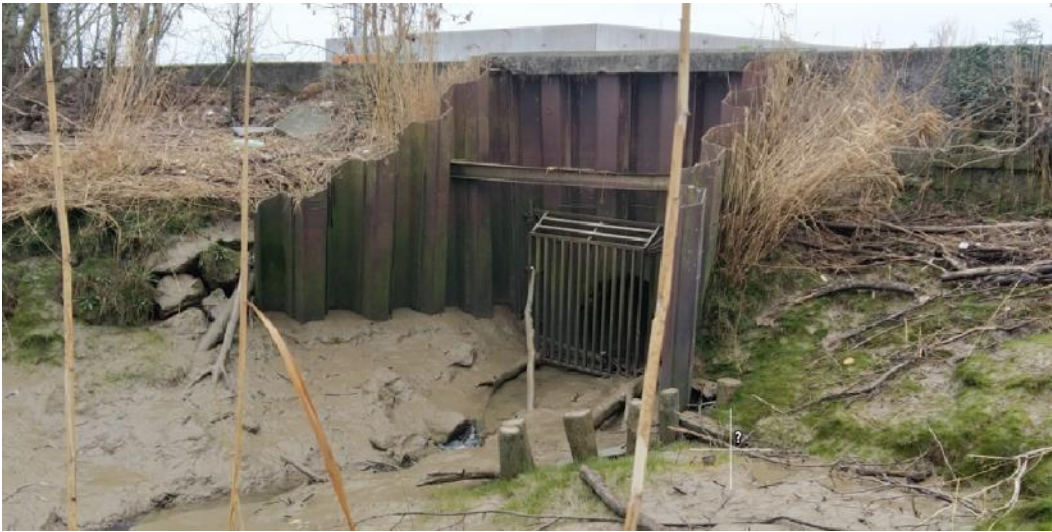
Figure 1 : Exemple d'un ouvrage avec rejet actuel au droit de la digue (avant travaux)
