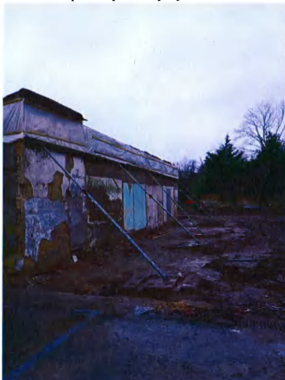
Photographie des opérations de déconstruction, confortation et mobilisation du potentiel en réemploi
