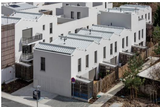
Photo chantier îlot 8.10 – Charme/P1 (ex CASTORAMA) -
