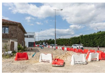
Travaux trottoirs avenue de la Somme (1.8) sept 2025
