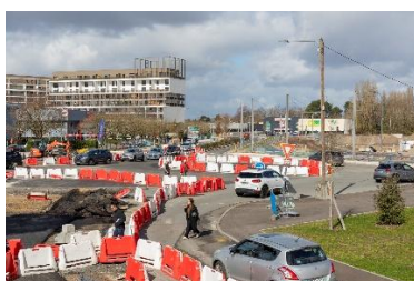
Travaux rond point Matosinhos (1.6) mars 2025
