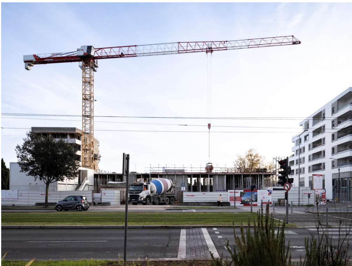
Travaux en cours sur le B3, © la Fab, Alexandre Dupeyron, novembre 2025
