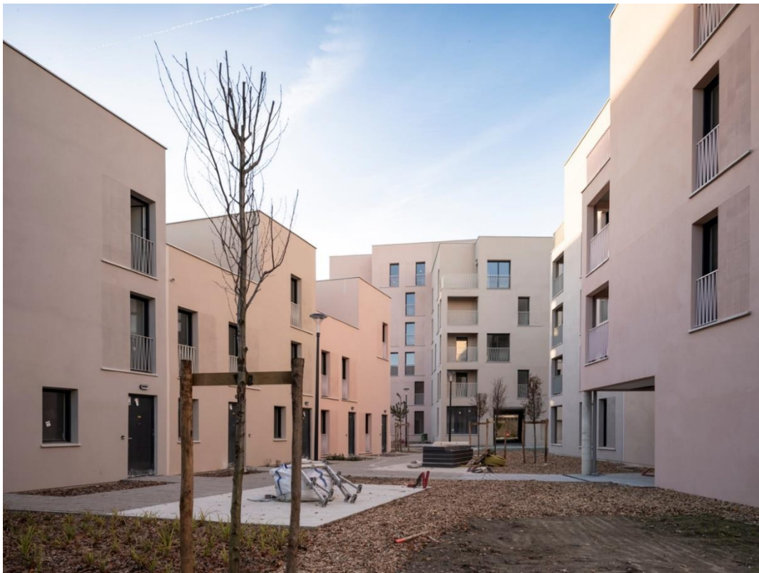
Ilot B7 en cours de travaux, ©Alexandre Dupeyron, juin 2025
