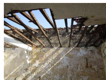
TRAVAUX EN COURS SUR LE CORPS AVANT
