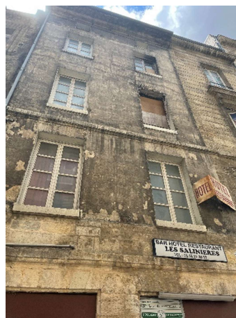
3 rue de la Fusterie – 6 rue des Pontets
