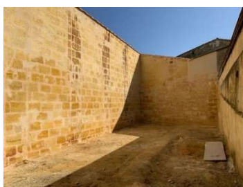
APRES DEMOLITION DU SECOND CORPS DE BATIMENT
