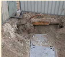
Racines endommagées par une tranchée
