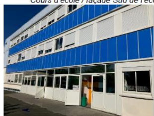
Façade Sud de l'école, sur cour
