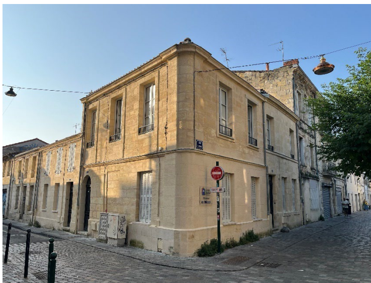
1 rue Bergeon, 3 rue Bergeon -12 rue Kléber 3 maisons de ville Gironde Habitat
