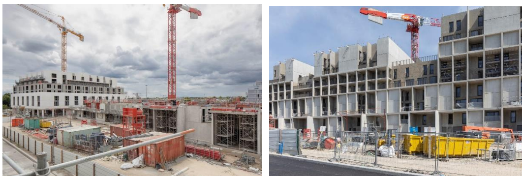
Photos chantier îlot 8.10- Tamaris (P4) (ex CASTORAMA) - septembre 2023 septembre 2024
