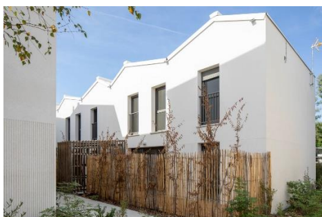
Photo chantier îlot 8.10 – Charme/P1 (ex CASTORAMA) -octobre 2023
