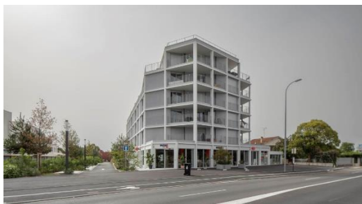
Photo chantier îlot 8.5 – Corylus/P5 (ex CASTORAMA) - septembre 2023
