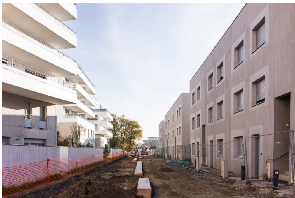
Travaux de la cour partagée 1 – Crédit photo La Fab
