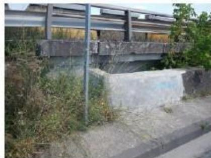
Le programme consiste en la démolition du muret actuel et la reconstruction d'un mur anti-crue. Les niveaux caractéristiques retenus par Bordeaux Métropole pour le système d'endiguement général de ce secteur, sont les suivants :
