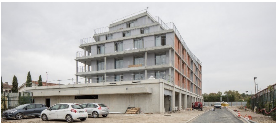
Photos chantier îlot 9.12 « CASTORAMA » - décembre 2022 © Sabine Delcour
