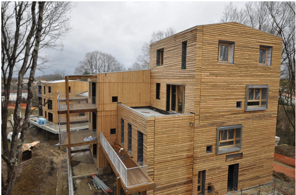
Chantier en cours de l'îlot B3- Naturaé (MOA ISA/ MOE Dauphins architecture)
