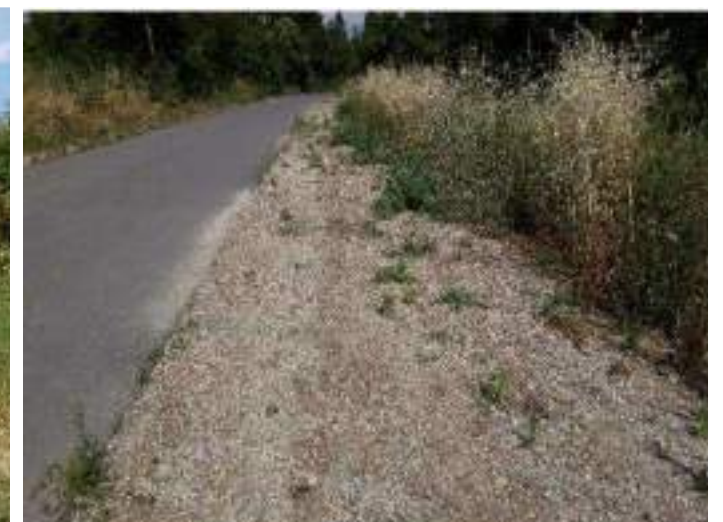
Piste cyclable aménagée voie Eymet (source : SEGED)
