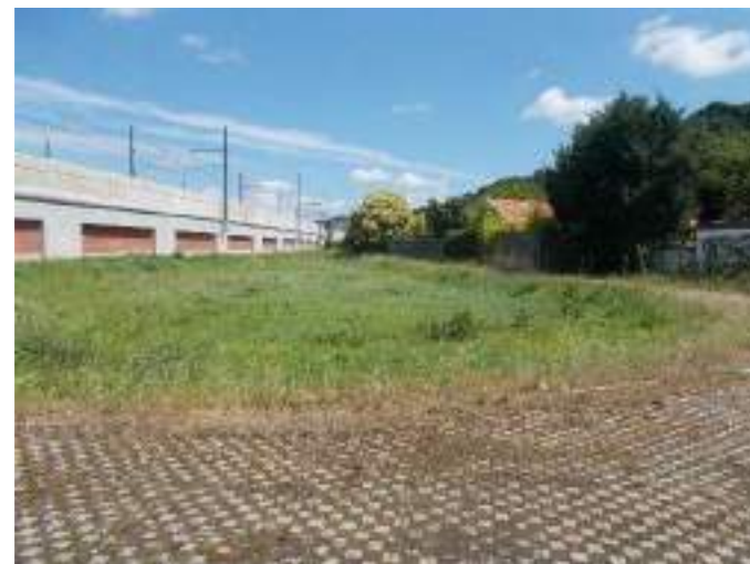
Bassin artificiel d'étalement des eaux usées Emile Combes (source : SEGED)
