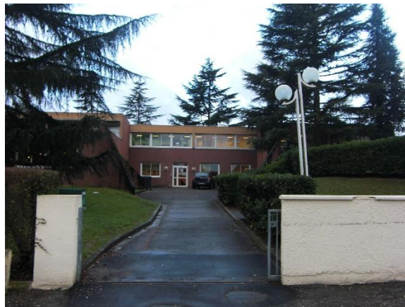
Entrée administrative depuis la rue J. Lurçat
