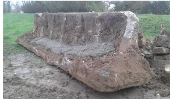
***Reprise de la digue en terre en lieu et place d'un ouvrage béton sans fondation***
