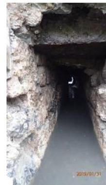
*Nettoyage et restauration de l'ouvrage traversant sous chaussée avec clapet à l'exutoire et voile béton*
