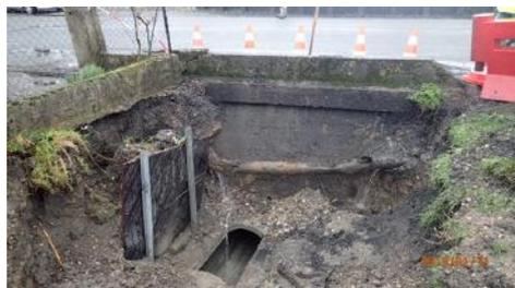
*Traitement des renards hydrauliques par la restauration du réseau d'évacuation et la mise en place d'une buse et d'un regard d'inspection pour l'entretien de l'ouvrage.*
