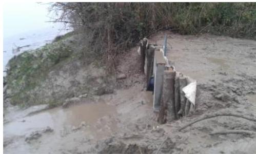
***Colmatage des renards hydrauliques dans la digue par la reprise de l'exutoire en Dordogne***
