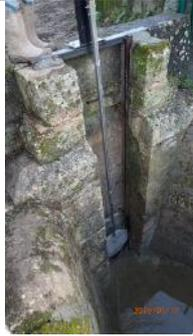
***Nettoyage de la pelle et colmatage des renards hydraulique amont / aval***
