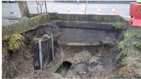
*Traitement des renards hydrauliques par la restauration du réseau d'évacuation et la mise en place d'une buse et d'un regard d'inspection pour l'entretien de l'ouvrage.*
