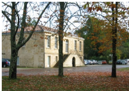
Ancienne maison de maître
