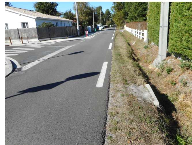
C 39 Absence de cheminement
