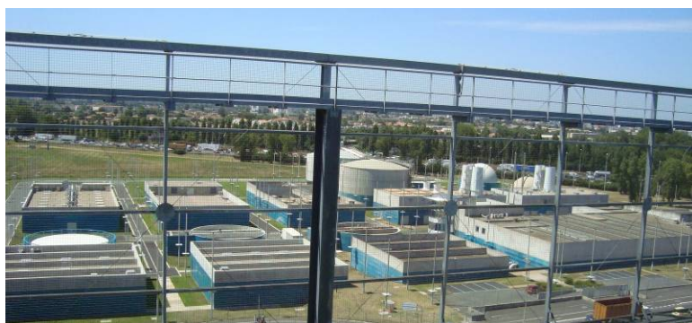
Station d'épuration « CLOS DE HILDE »
