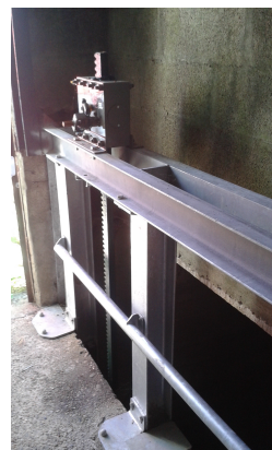
Ouvrage hydraulique neuf
