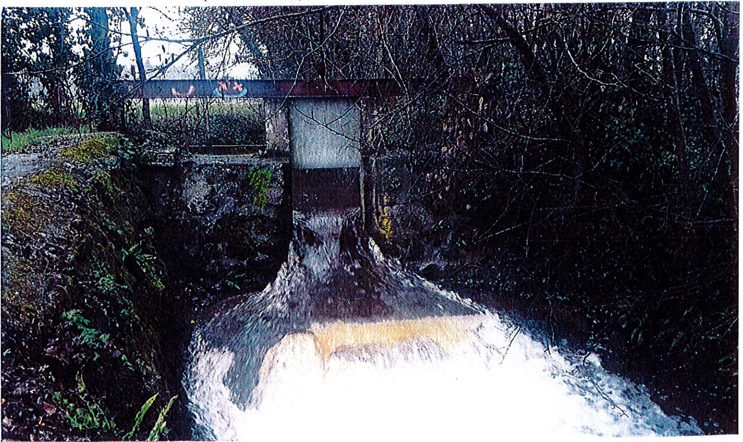
OUVRAGE 1: (aval du château)
