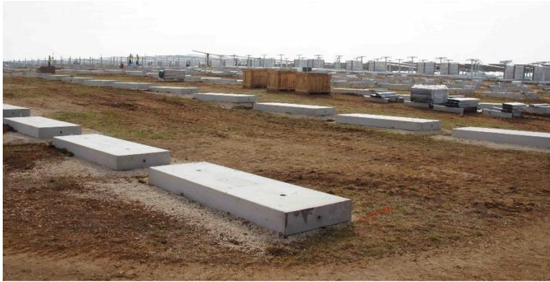
Figure 11 : Exemple de longrine en béton
