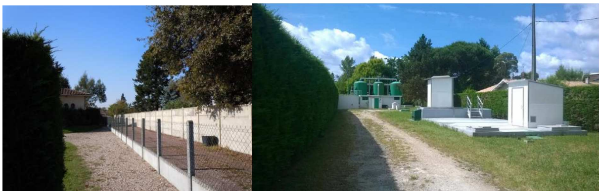
Allée privée et captage de Ruet – La Fab
