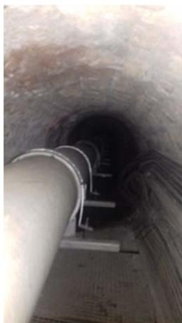
Ensuite, une canalisation de diamètre 300mm en fonte grise, datant de 1920, implantée à l'intérieur d'une galerie souterraine traversant les voies ferrées jusqu'à la rue des Terres de Borde, a été déposée et remplacée par une canalisation en polyester renforcé de verre (PRV) de diamètre 400mm.
