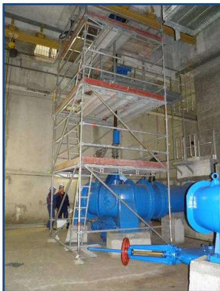
Noutary (poste de relevage sélectif) : installation d'un échafaudage pour les travaux
