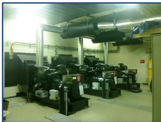
Bas Bouscat 2 : poste de relevage pluvial : enlèvement des groupes électrogènes (à gauche) et nouveaux groupes électrogènes (à droite)
