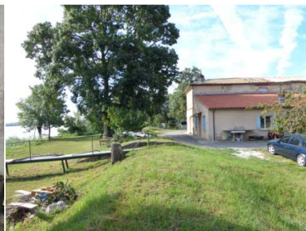
Figure 52 : Habitation en arrière des digues à Saint-Vincent-de-Paul. - Source : Bordeaux Métropole -2013
