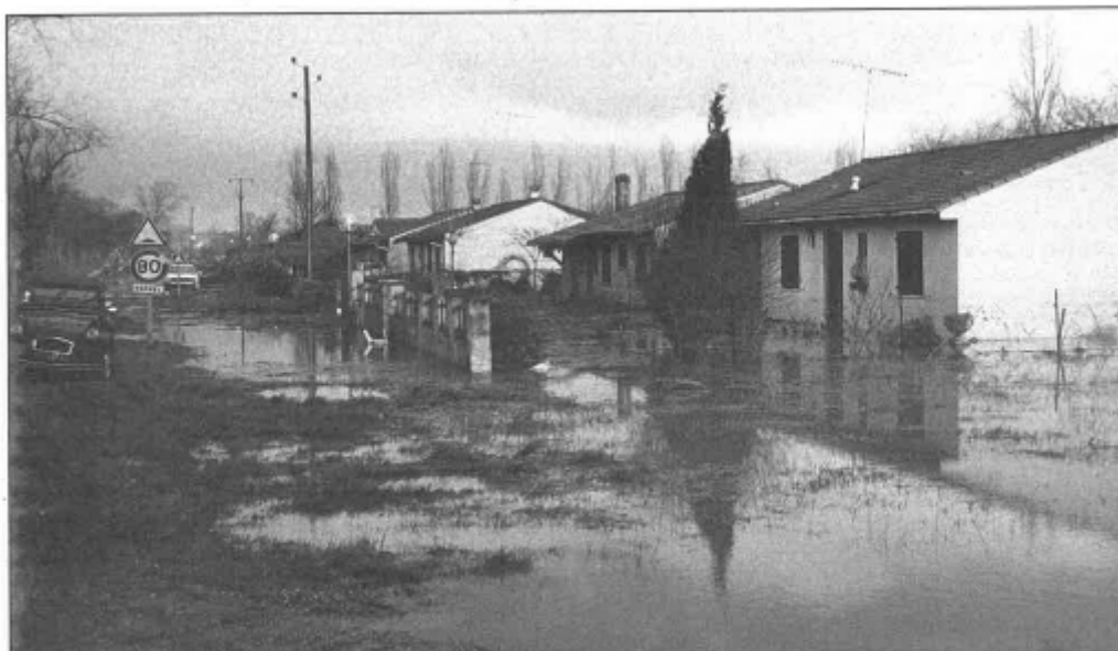
Figure 37 : Lotissement du Mail lors de la Tempête 1999 – Source : Mairie de Labarde
