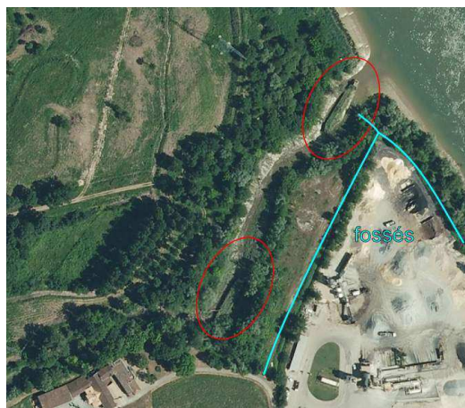
Figure 140 : Epaves dans le lit de l'Eau Blanche - Source : Etude de danger des digues de Plabo S.A.S – 2014 – Bordeaux Métropole
