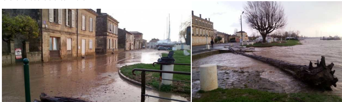
Figure 54 : Inondation du 11 janvier 2016 sur le port de Bourg- Source : Sud Ouest - ©JeromeJamet
