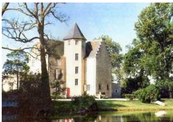
Figure 76: Châteaux de Franc, Bègles - Source : Mairie de Bègles
