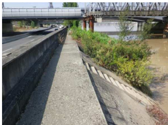
Figure 110 : Digue de type rideau palplanches - ouvrage de Saint-Jean-Belcier : Source : EPA - Etude de danger de la digue Saint-Jean Belcier - 2013
