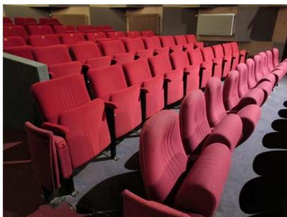
Les revêtements intérieurs de la salle sont globalement vétustes. Une partie des fauteuils a été remplacée, mais ces derniers sont dans l'ensemble en mauvais état.
