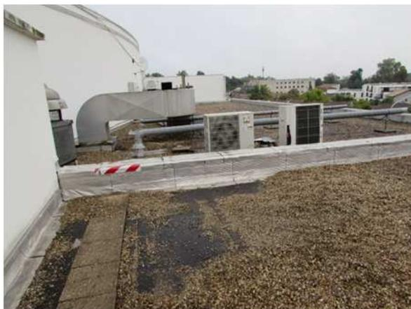
Nous n'avons pas pu accéder à la partie supérieure de la toiture terrasse, étanchée par une membrane bitumineuse auto-protégée.
