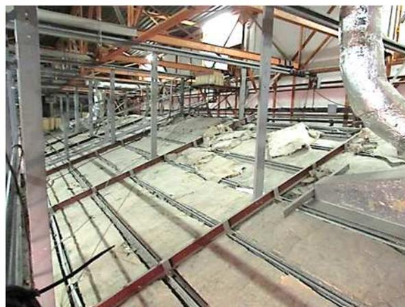
L'isolant au-dessus de la salle est vétuste et en mauvais état. **Il y a suspicion de présence d'amiante dans cet isolant.** Nous avons été informés que des capteurs de mesure de l'empoussièrement ont été mis en place dans la salle. **Cette problématique est à suivre avec attention, elle pourrait entraîner des travaux de désamiantage à court terme.**
