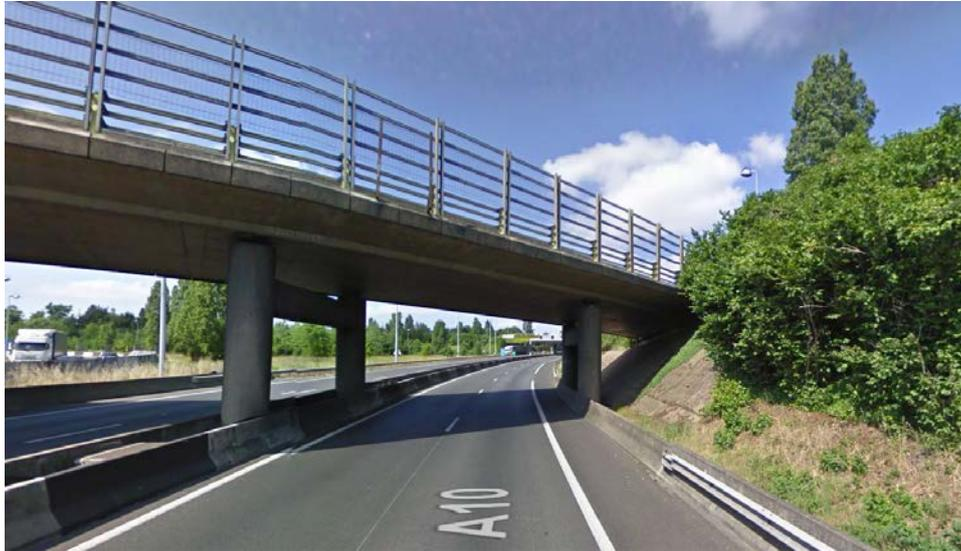
**Figure 12 : Piles de rive sous l'un des PS de l'échangeur n°1 (source : Google)**
