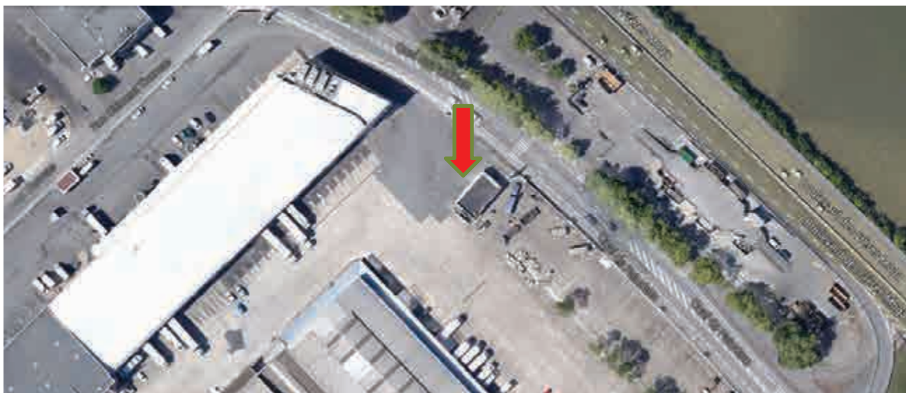
Localisation de la chaufferie du M.I.N.
