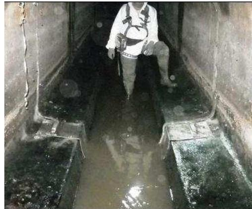
Une sonde ou plusieurs sondes doppler (en fonction de la géométrie du collecteur) mesurant la vitesse de l'effluent sont placées sur le radier du collecteur. Cette mesure de vitesse est couplée à une mesure de hauteur intégrée à la sonde ou externe pour déterminer le débit.
