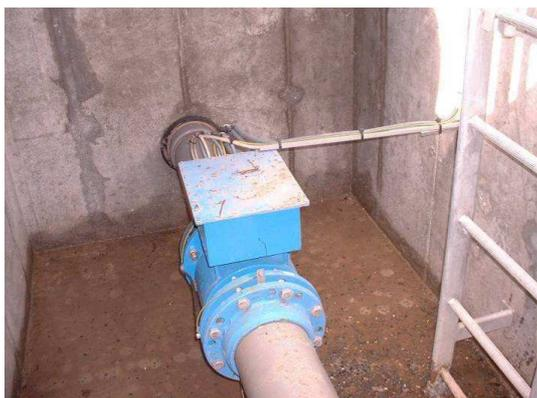
Une manchette électromagnétique est insérée sur la conduite dans une fosse rectangulaire de 1,50 x 1,50 m.
