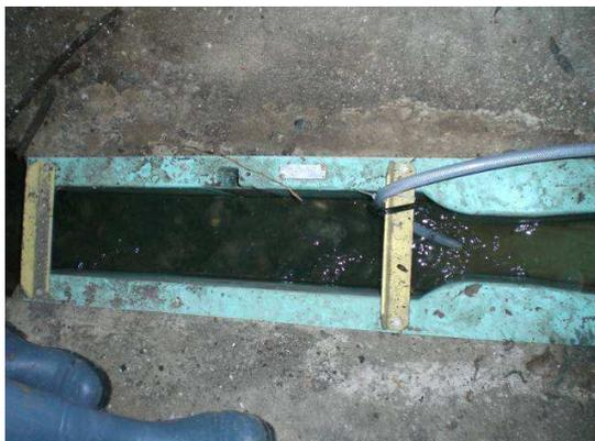
Un canal venturi est inséré sur la conduite dans une fosse rectangulaire de 3,00 x 1,50 m. Une mesure de hauteur permet de mesurer le débit grâce à une loi mesure / hauteur.
