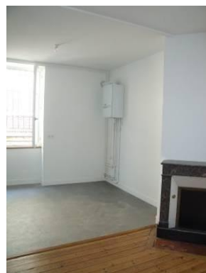
Photos après travaux
