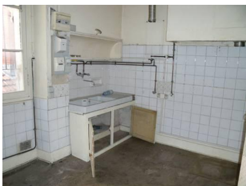
Logement LCS - 11, rue Judaïque Bordeaux - Avant travaux
