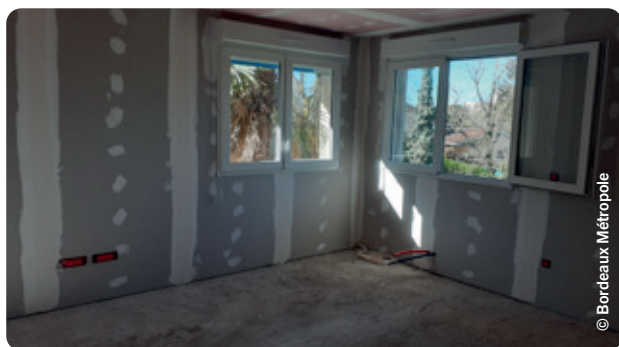
Travaux en cours maison « Prado » Eysines
