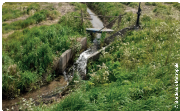
Exutoire de la prise d'eau du Moulin Noir alimentant le secteur de Langlet
