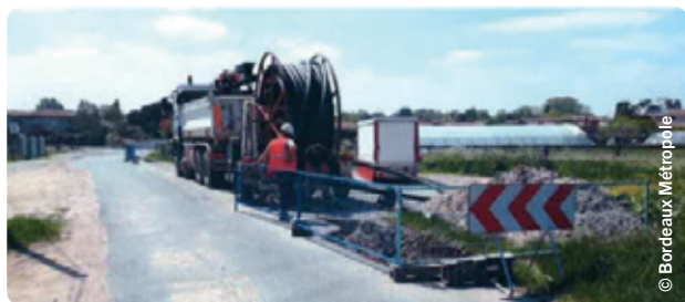
Chemin de Langlet - travaux eau potable
