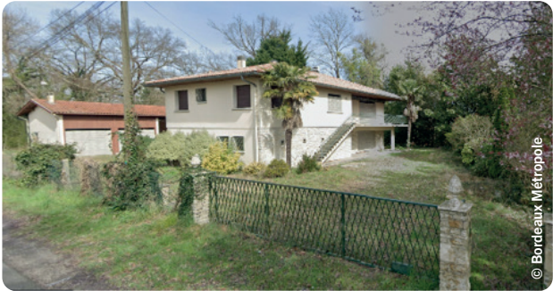
Maison « Prado » à Eysines acquise en 2021
