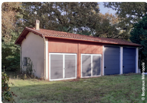
Hangar Prado – Eysines -Travaux de sécurisation réalisés en 2024
