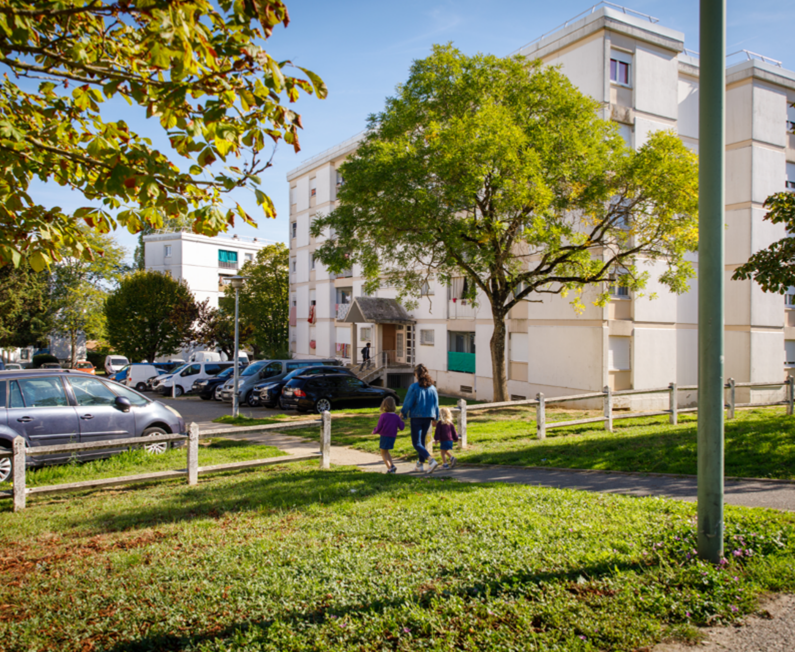
Résidence avant travaux, avenue Camille Jullian, octobre 2025 © C Barbier – Bordeaux Métropole
