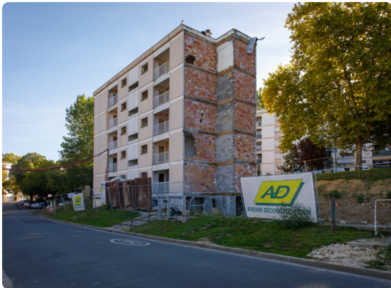
Démolition Bas Carriet, octobre 2025. © C Barbier - Bordeaux Métropole
