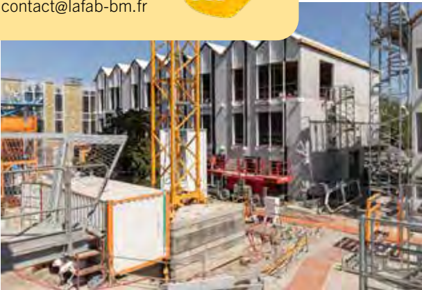
Chantier de l'îlot 1, mai 2025. Source : Sabine Delcour
