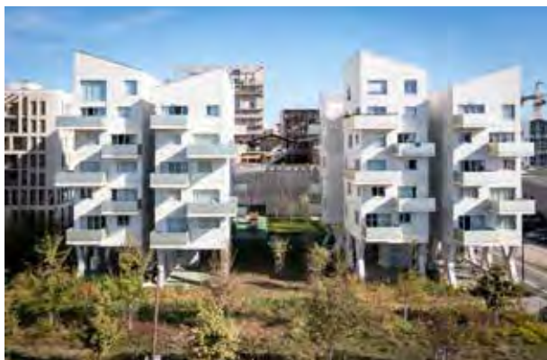
Bâtiments sur pilotis (Aquitanis), octobre 2023.
