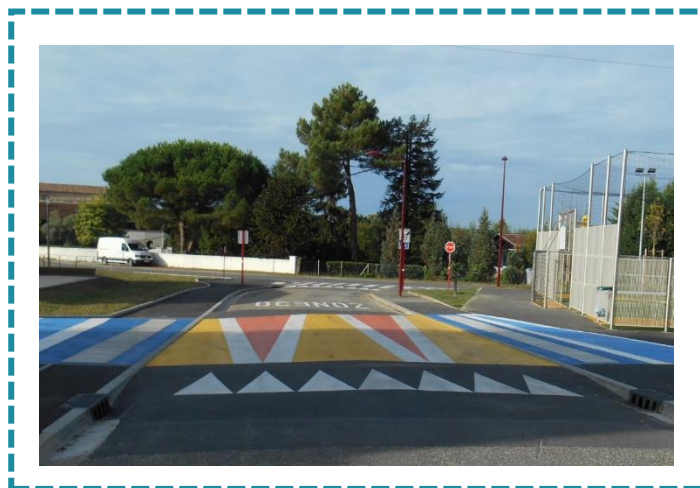
Fig. 1 : marquage d'animation réalisé à Bassens Source : Bordeaux Métropole
