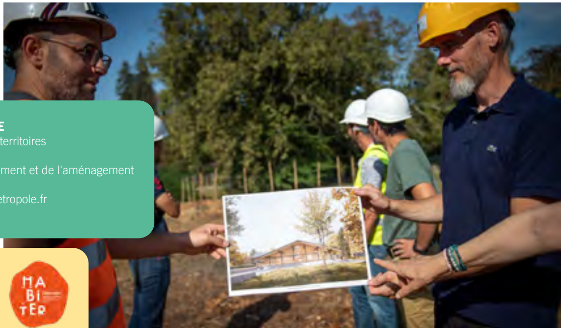
Chantier du groupe scolaire, septembre 2023. Source : Christophe Goussard.
