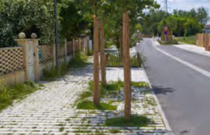
Requalification de la rue Martin Porc, juin 2023. Source : Pierre Filliquet, La Fab
