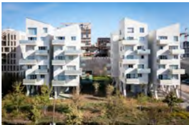
Bâtiments sur pilotis (Aquitanis), octobre 2023.
