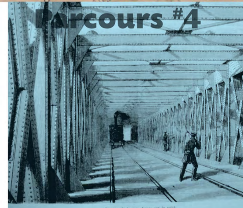
Passerelle de la voie ferrée sur le pont.
