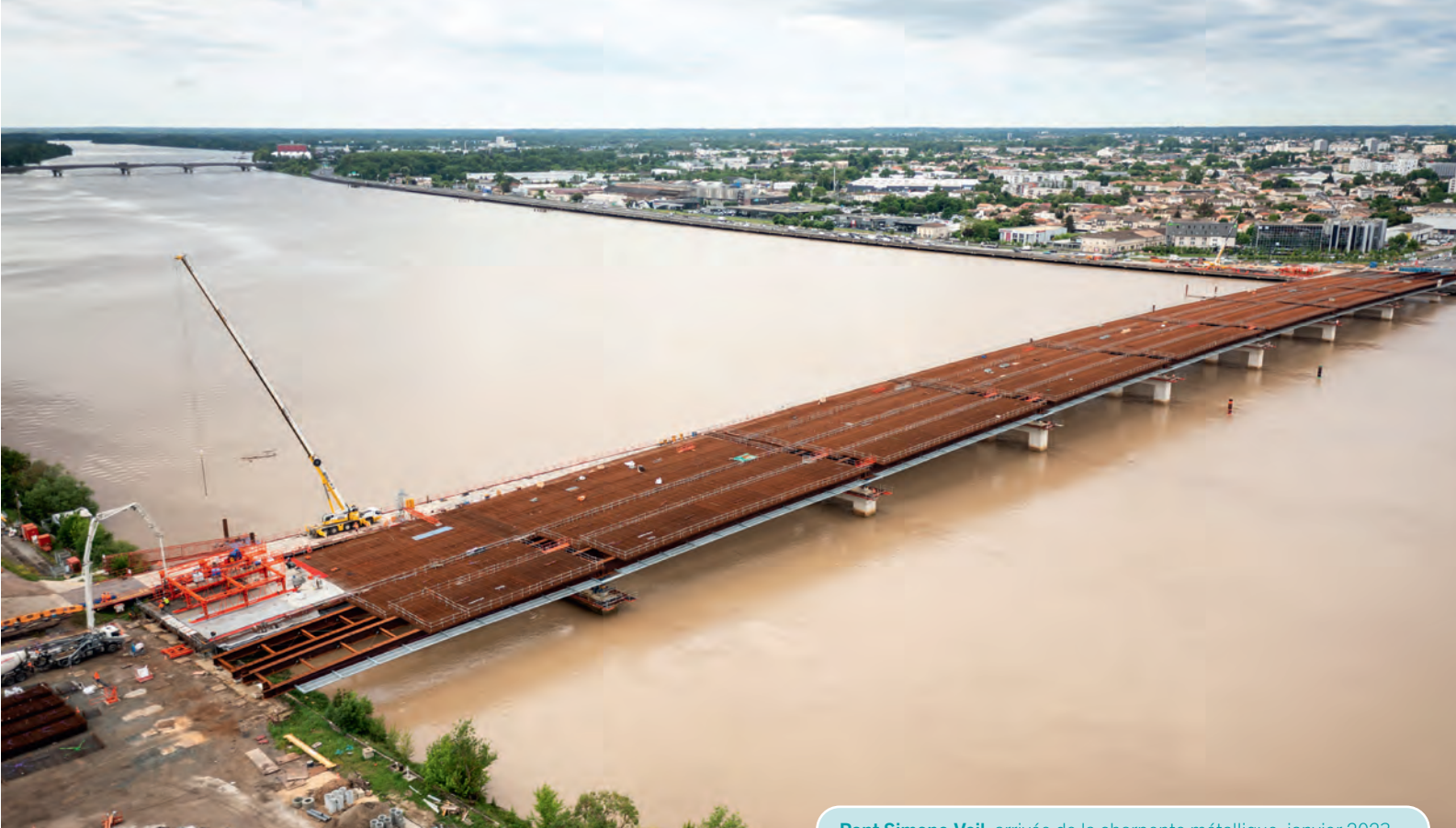
Pont Simone-Veil, arrivée de la charpente métallique, janvier 2023
