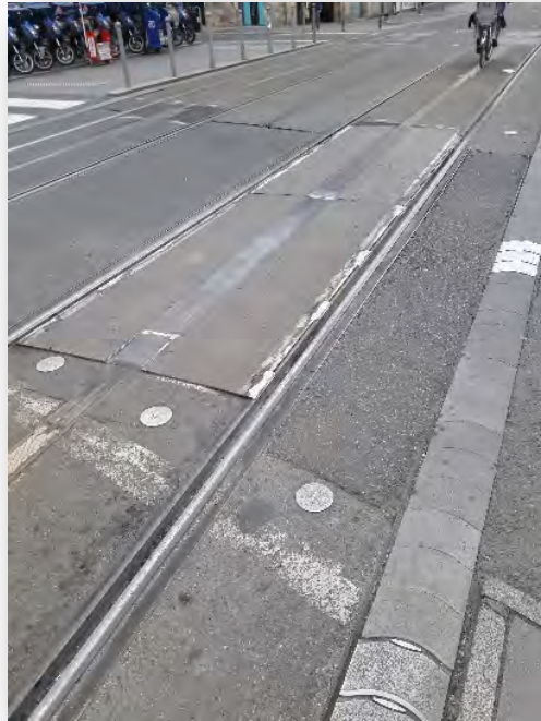
Exemple de rustines apposées sur les rails APS (carrefour Saint-Genès)
