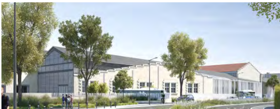
Vue depuis le Boulevard Pompidou
