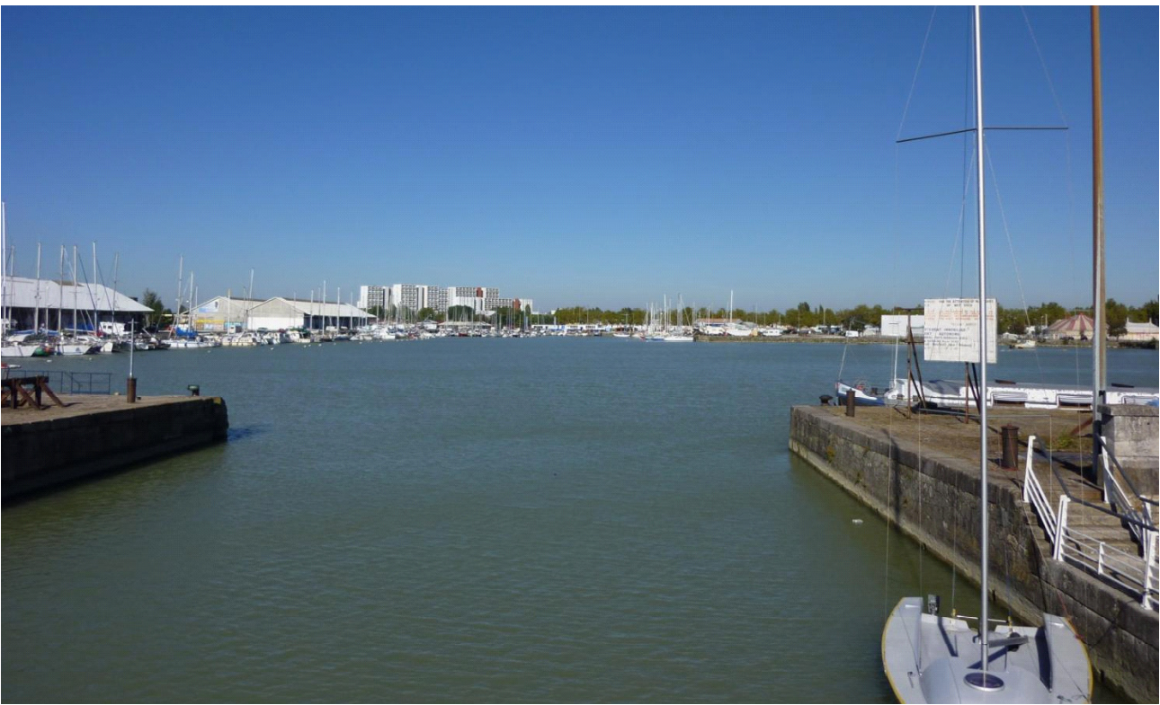
Vue sur le bassin n°2
