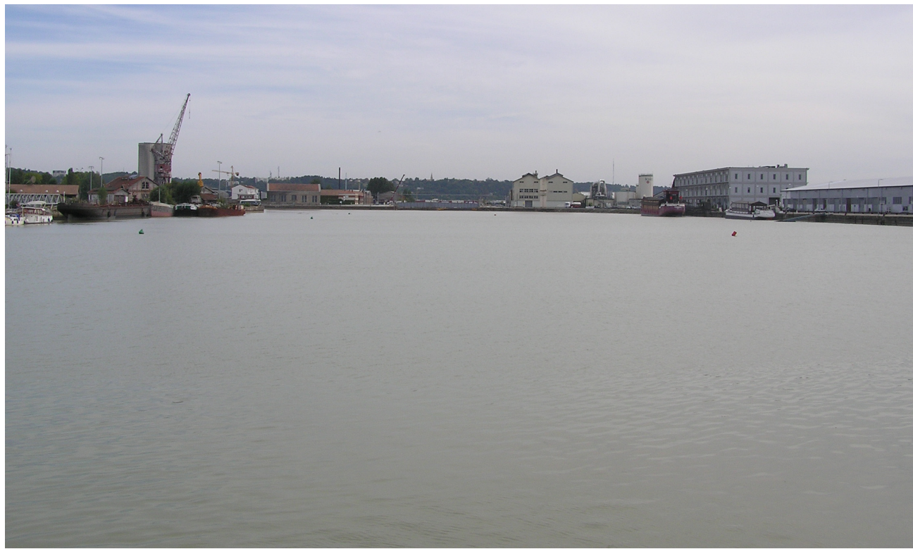
Vue sur le bassin n°1
