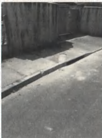
PHOTOGRAPHIE 3 - PAT.3.2. Rue des Genêts - LE HAILLAN - Mise en place de pré-bouche sur bouche d'égout existante
