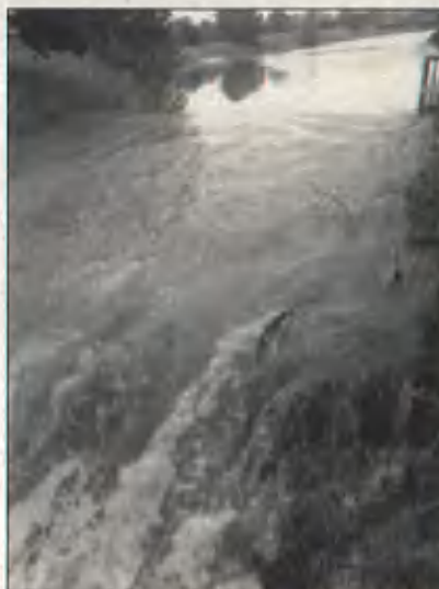
Surverse du bassin de Tresses le 1er mai 2020
