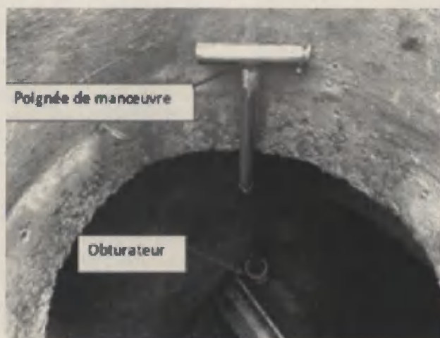
PHOTO 1 Système de fermeture du piquage Jaurès
