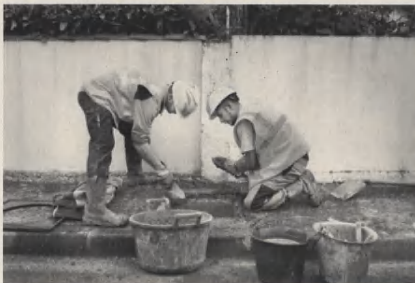
PHOTOGRAPHIE 1 - EXPL.4.4 Travaux de rescelllement d'un regard sur trottoir pour les agents des réparations du département réseaux.
