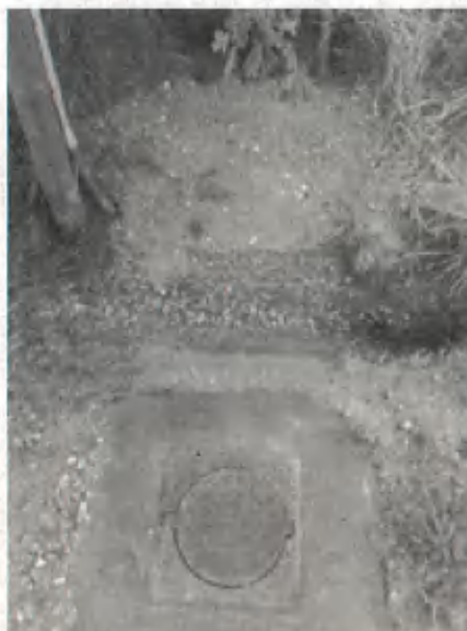
PHOTOGRAPHIE 1 et 2 - PAT.3.2. Avenue du Roy - Ambarès - Déplacement de regards de façade EU, afin de supprimer les entrées d'eaux de fossé dans les réseau d'eaux usées - photo avant/après
