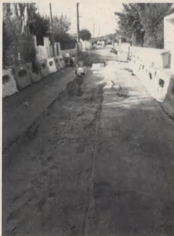
PHOTOGRAPHIE 11 - PAT.3.2 : Chantier d'urgence Bloc F : rue Alphonse Daudet à PESSAC
