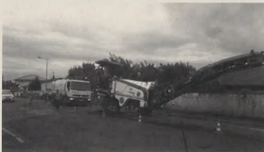
PHOTOGRAPHIE 1 - EXPL.4.3 Rabotage de voirie
