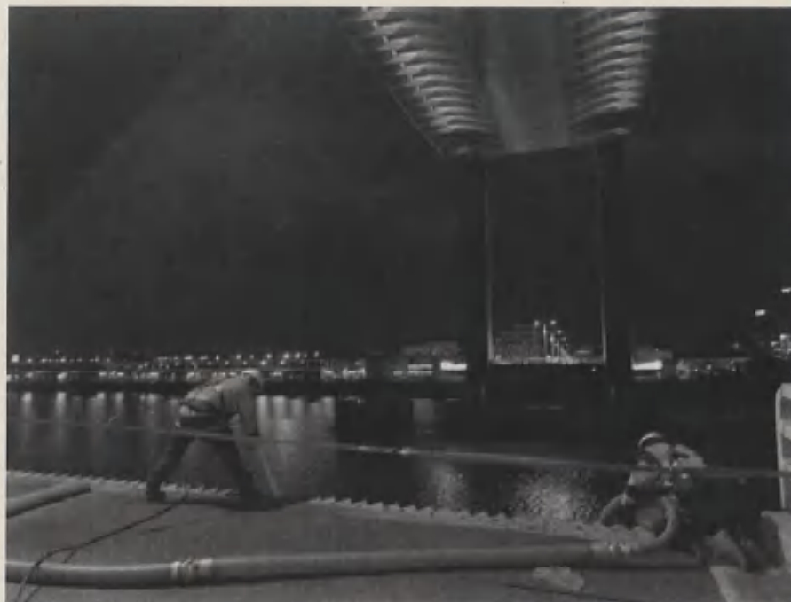
PHOTOGRAPHIE 5 - EXPL.5.1. Travaux réalisés de nuit sur le pont Chaban Delmas en janvier 2020
