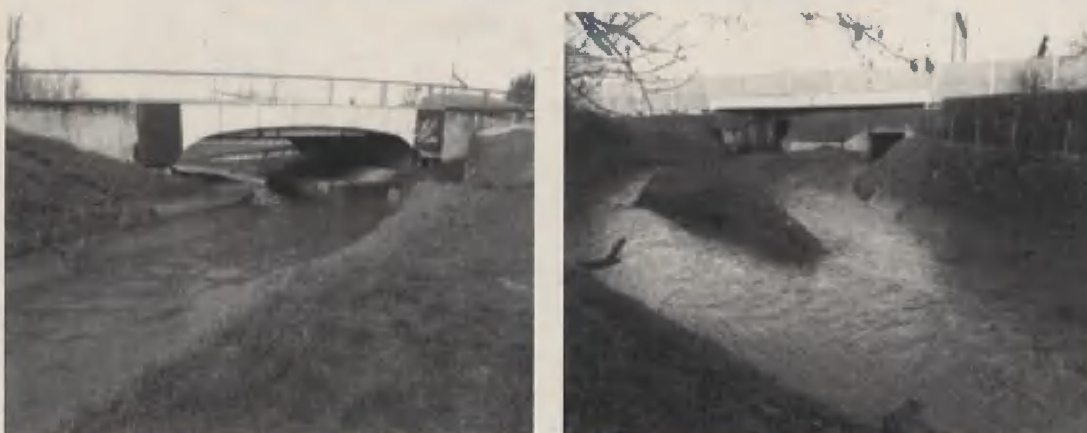
Aval de l'Archevêque pont de la Gorp routier et SNCF Paris
