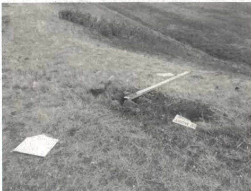
PHOTOGRAPHIE 1 - EXPL.8.2 Panneau cassé au bassin de Béquigneaux
