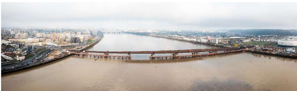
Depuis la première opération de lancement le 8 mars 2022, l'entreprise Baudin-Châteauneuf a poursuivi les travaux d'assemblage de la charpente métallique du pont sur la rive droite et les opérations de lançages successifs. Cette phase devrait s'achever en totalité avec la mise en place de la charpente de 5 800 tonnes (l'équivalent de 75 % du poids total de la charpente de la Tour Eiffel) sur ses appuis définitifs fin juillet 2023.
