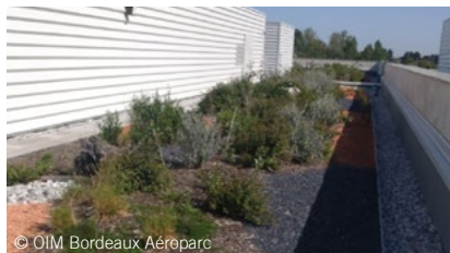
Toiture végétalisée extensive Community - Métrignac
