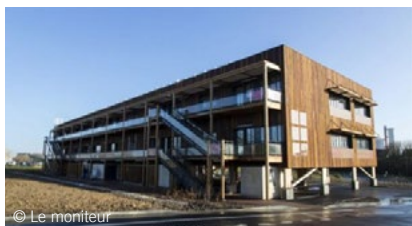
Bâtiment biosourcé et démontable au Havre
