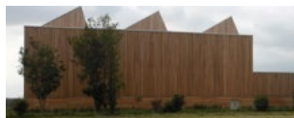
Bâtiment de stockage de l'entreprise Pocheo en structure bois-béton © Ingebois
