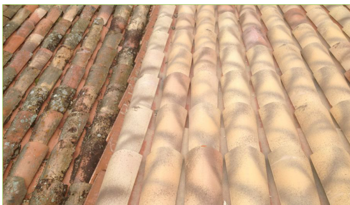
Tuile canal ancienne et neuve
