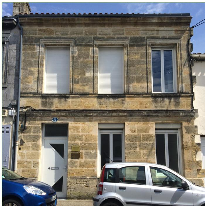
Les menuiseries extérieures et les volets roulants en PVC ne sont pas adaptés au bâti ancien. Le dessin des menuiseries et les coffres de volet roulant sous linteaux ne permettent pas une réhabilitation de qualité.
