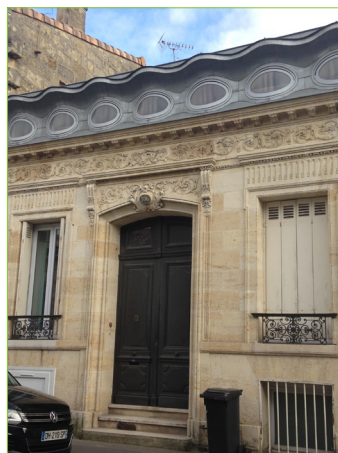
Surélévation d'une échoppe bordelaise -B. Nivelles architecte
