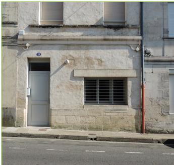
L'agrandissement de la fenêtre du rez-de-chaussée a des proportions inadéquates dans la composition de la façade
