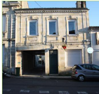
Les alignements horizontaux et verticaux sont respectés, mais l'agrandissement d'une baie à rez-de-chaussée ne respecte pas le principe de composition d'origine de la façade
