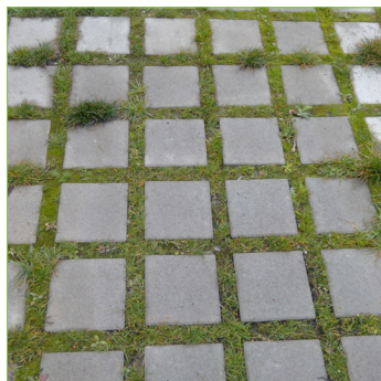
Pavés à joints enherbés
