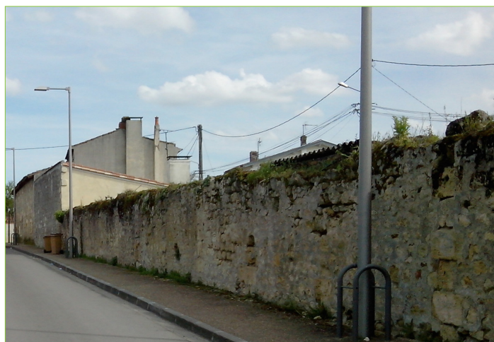
Rue du Prince Noir - mur en pierre de taille et moellons (mur de clôture)
