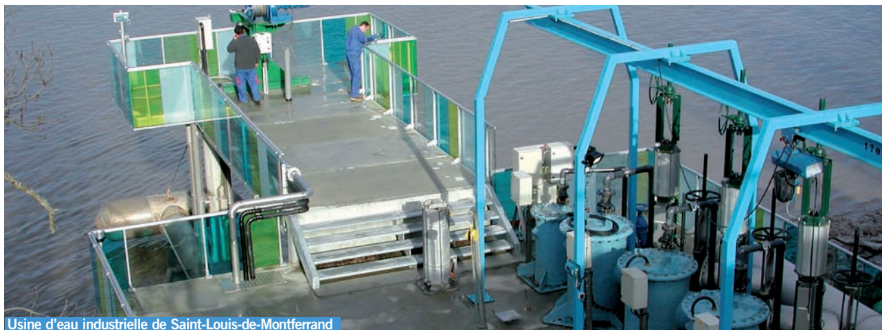
Usine d'eau industrielle de Saint-Louis-de-Montferrand
